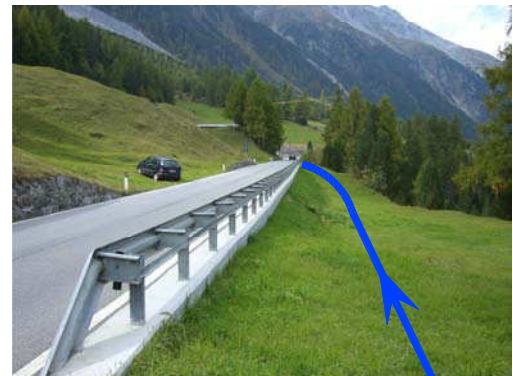
Foto 04 - Hauptkanalisation (Druckleitung) in Wiese neben SS 622
