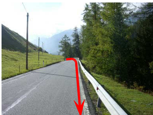
Foto 42A (rückwärts) - Hauptkanalisation in SS 622
