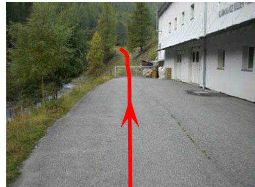
Foto 02 - Beginn Hauptkanalisation (Druckleitung) Pumpstation bei Kläranlage Suldén
