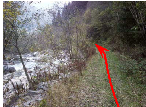
Foto 72 - Hauptkanalisation unter Weg neben Suldenbach
