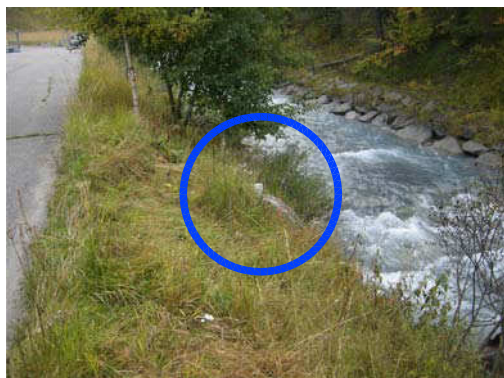
Foto 01 - Beginn Hauptkanalisation bei bestehender Rückgabe
