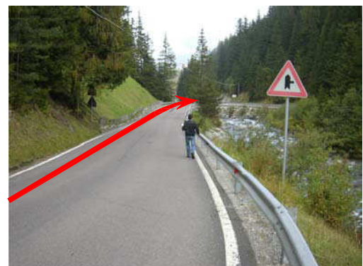
Foto 32 - Hauptkanalisation in SS 622
