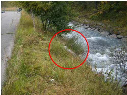
Foto 01 - Beginn Hauptkanalisation bei bestehender Rückgabe
