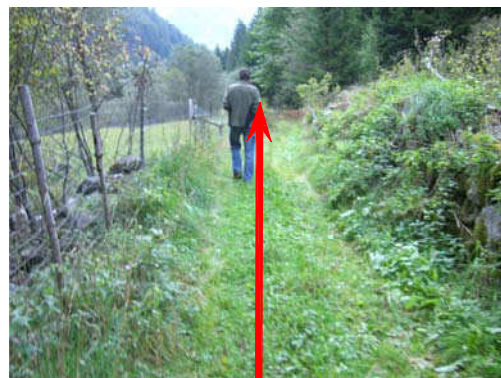
Foto 78 - Hauptkanalisation unter Wiesenweg
