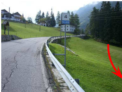
Foto 47 ( rückwärts ) - Hauptkanalisation in Wiese unterhalb der Gandhöfe
