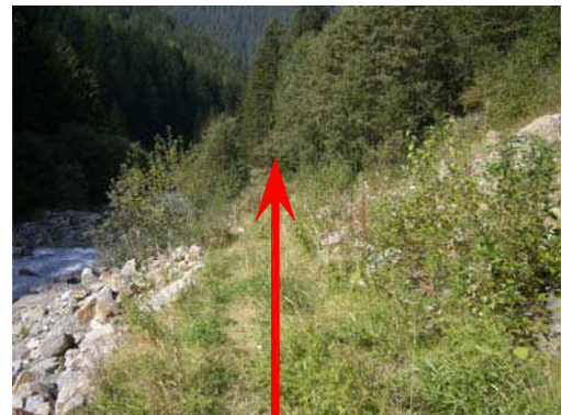
Foto 66 - Hauptkanalisation unterhalb Weg entlang Suldenbach
