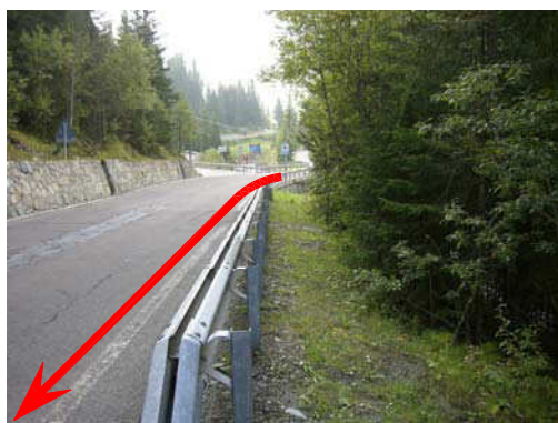
Foto 37 ( rückwärts ) - Hauptkanalisation in SS 622
