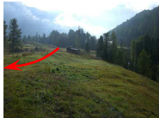
Foto 06 - Hauptkanalisation (Druckleitung) in Wiese
