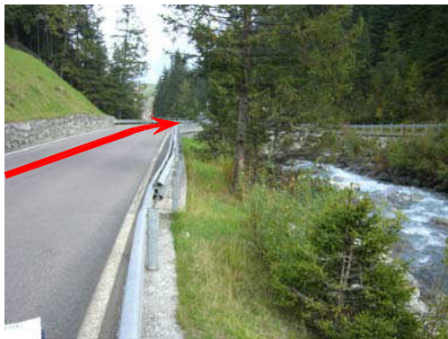
Foto 33 - Hauptkanalisation in SS 622
