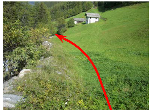
Foto 54 - Hauptkanalisation unter Wiesenweg vor Putzen
