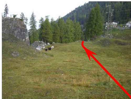
Foto 07 Hauptkanalisation (Druckleitung) in Wiese
