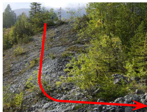
Foto 24 - Hauptkanalisation im freien Gelände unterhalb Kehre SS 622
