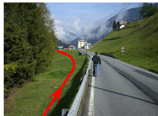
Foto 42B - Hauptkanalisation in Wiesen vor Laganda
