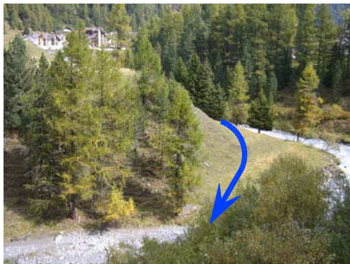
Foto 03 ( rückwärts ) - Hauptkanalisation (Druckleitung) seitlich Suldénbach vor Unterquerung
