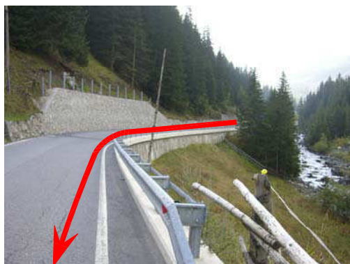
Foto 39 - ( rückwärts ) - Hauptkanalisation in SS 622
