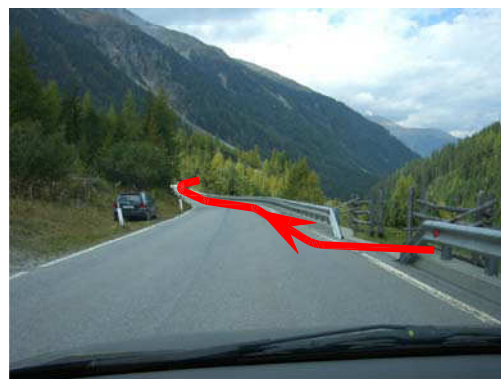
Foto 12 - Hauptkanalisation (Druckleitung) unterhalb Straße
