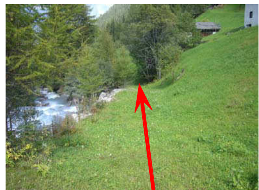
Foto 56 - Hauptkanalisation in Wiese neben Suldenbach vor Putzen
