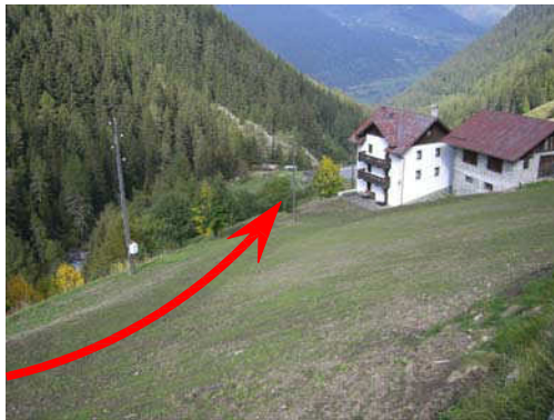
Foto 49 - Hauptkanalisation unter Wiesenweg
