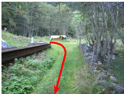
Foto 77 (rückwärts) - Hauptkanalisation unter Wiesenweg
