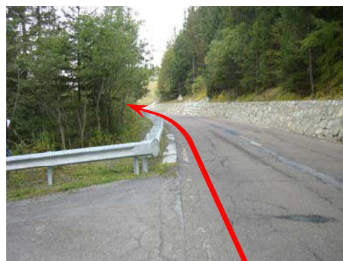
Foto 38 - Hauptkanalisation in SS 622
