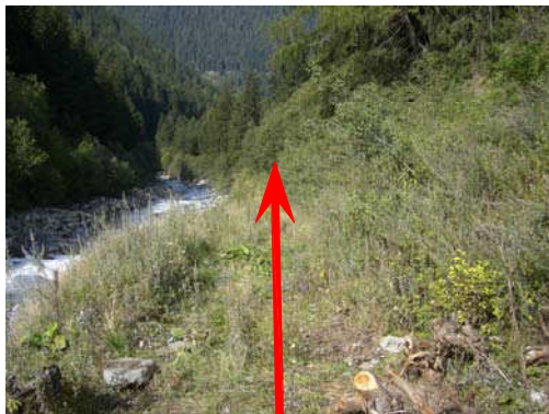
Foto 65 - Hauptkanalisation unterhalb Weg entlang Suldenbach
