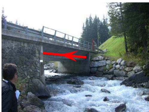
Foto 35 - Hauptkanalisation Montage seitlich an der Karnerbrücke
