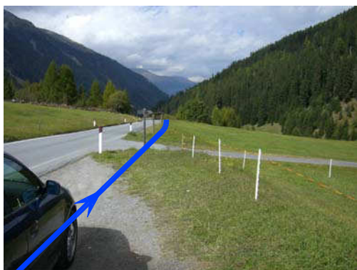
Foto 07 - Hauptkanalisation (Druckleitung) in Wiese neben SS 622
