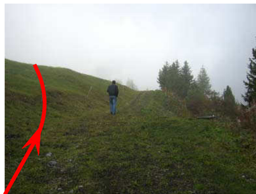
Foto 10 - Hauptkanalisation (Druckleitung) in Wiese unterhalb Ortlerhof
