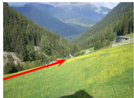
Foto 52 - Hauptkanalisation in Wiesen
