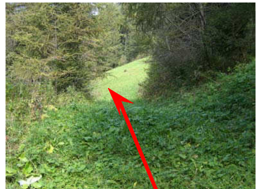
Foto 58 - Hauptkanalisation unter Wiesenweg
