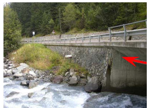
Foto 36 - Hauptkanalisation Montage seitlich an der Karnerbrücke
