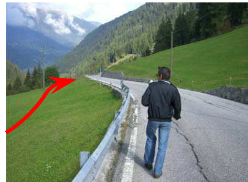
Foto 48 - Hauptkanalisation in Wiesen
