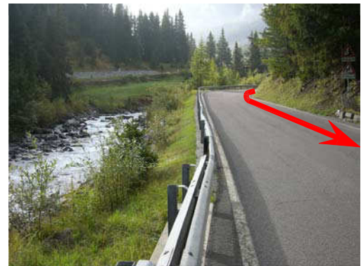
Foto 34 (rückwärts) - Hauptkanalisation in SS 622
