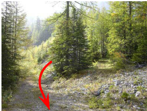
Foto 25 (rückwärts) - Hauptkanalisation neben Suldenbach unter Weg
