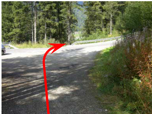
Foto 69 - Hauptkanalisation Querung SS622 neben Suldenbachbrücke
