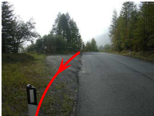
Foto 17 (rückwärts) - Hauptkanalisation seitlich SS 622
