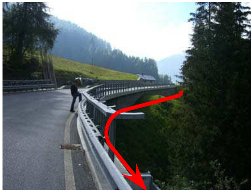
Foto 45 - Überquerung Razoi Bach bei Brücke
