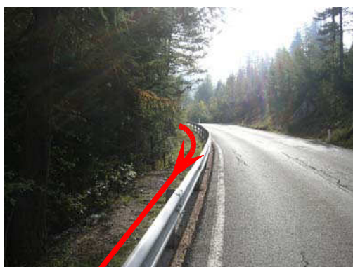
Foto 21 (rückwärts) - Hauptkanalisation seitlich SS 622
