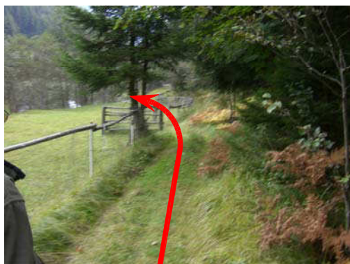
Foto 78 - Hauptkanalisation unter Wiesenweg
