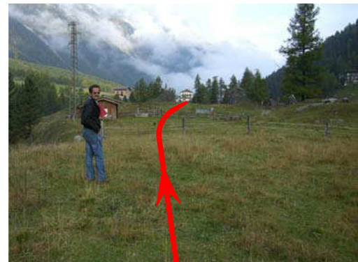
Foto 04 - Hauptkanalisation (Druckleitung) in Wiese
