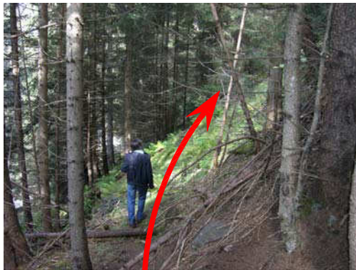
Foto 61 - Hauptkanalisation im Wald
