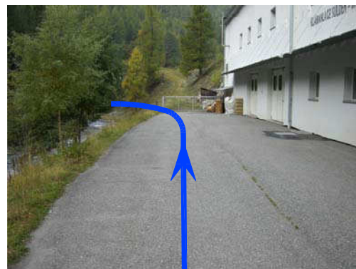
Foto 02 - Beginn Hauptkanalisation (Druckleitung) bei Kläranlage Suldén
