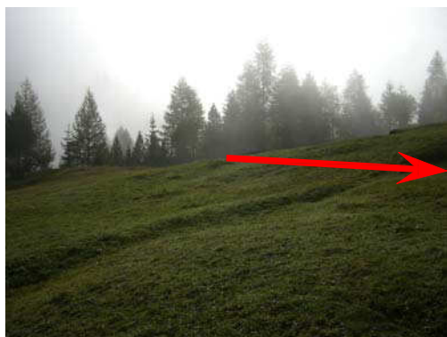
Foto 11 - Hauptkanalisation (Druckleitung) in Wiese
