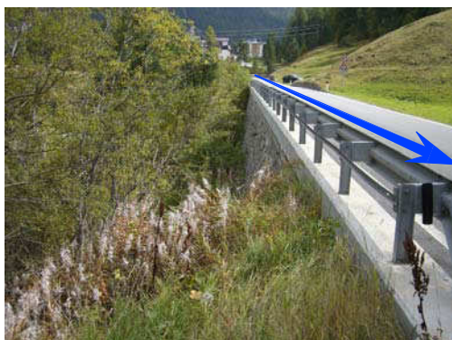
Foto 05 ( rückwärts ) - Hauptkanalisation unterhalb SS 622
