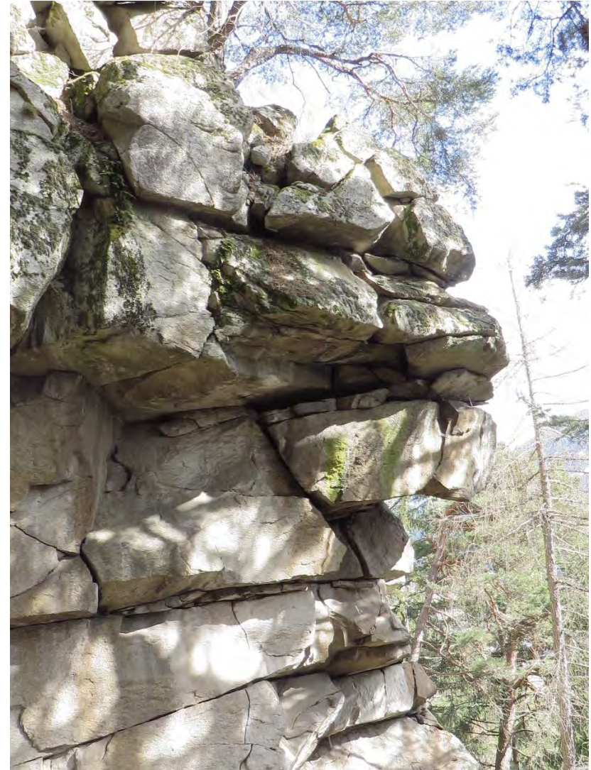
Zone A7: Detaillansicht; der aufgelockerte Bereich wird mit 9 Glasspionen versehen, die alle intakt sind
