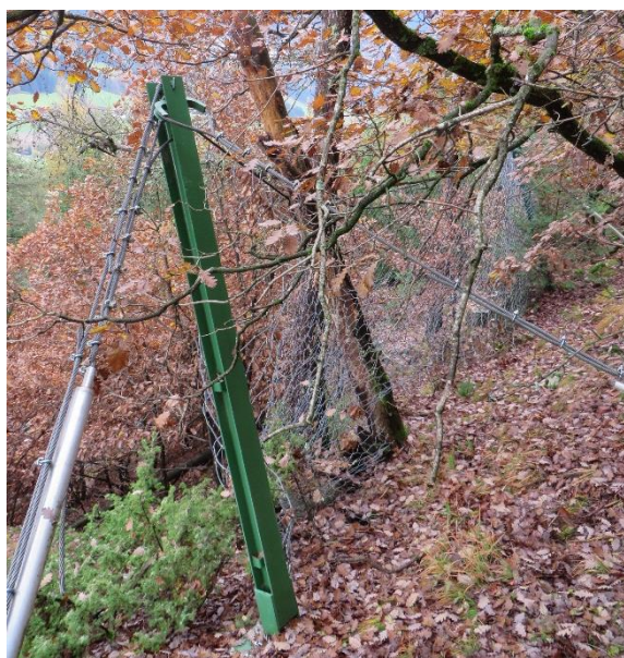
Foto1: Elastische Barriere: Energiehaltevermögen max. 1000 kJ; km 1+175 – 1+215; km 1+450 – 1+500./ Barriere deformabile, capacità di trattenuta di energia max: 1000 kJ; km 1+175 – 1+215; km 1+450 – 1+500
