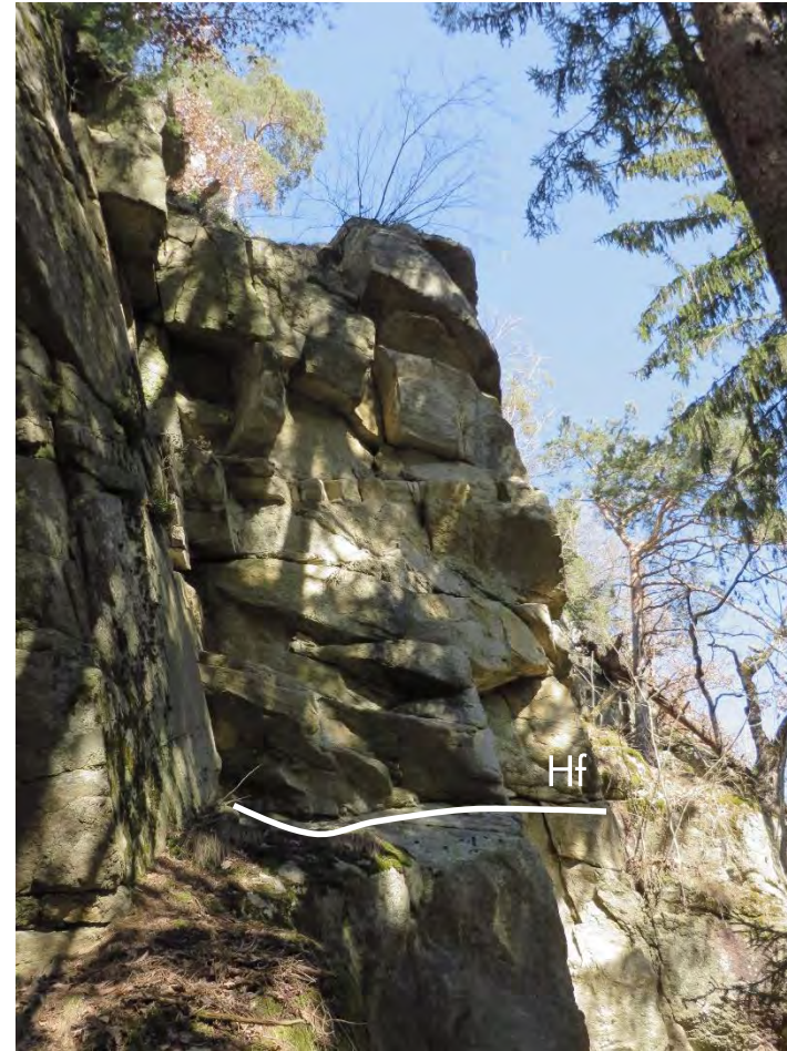
Zone C2: Harnischfläche Hf(225/42) begrenzt Felskörper und ermöglicht ebenes Gleiten in Richtung SW; max. Einzelblockvol. bis 3,0 m 3 Zona C2: piano di scivolamento Hf(225/42) delimita corpo roccioso; potenziale scivolamento in direzione SW: volume max. blocco singolo sino a 3,0 m 3
