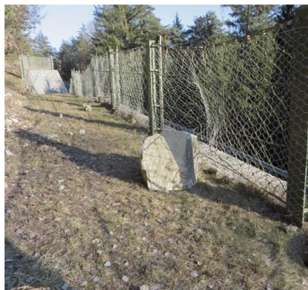
Foto 2: Starre Barriere: Energiehaltevermögen max. 500 kJ; bergseitige Böschungsmauer./ Barriera rigida, capacità di trattenuta di energia max: 500 kJ; sul muro di scarpata al lato monte
