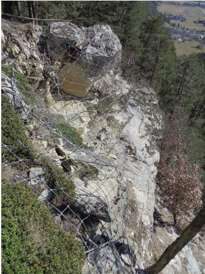
Zone C3: Mit Netzpanele und Felsnägel gesicherte Zone
