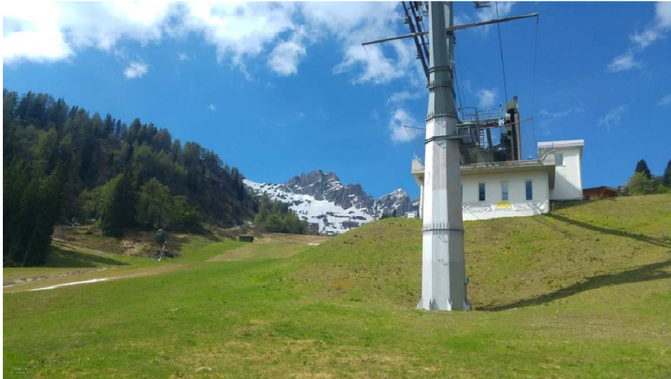
Figura 8: Panoramica della zona della stazione a monte dell'impianto
