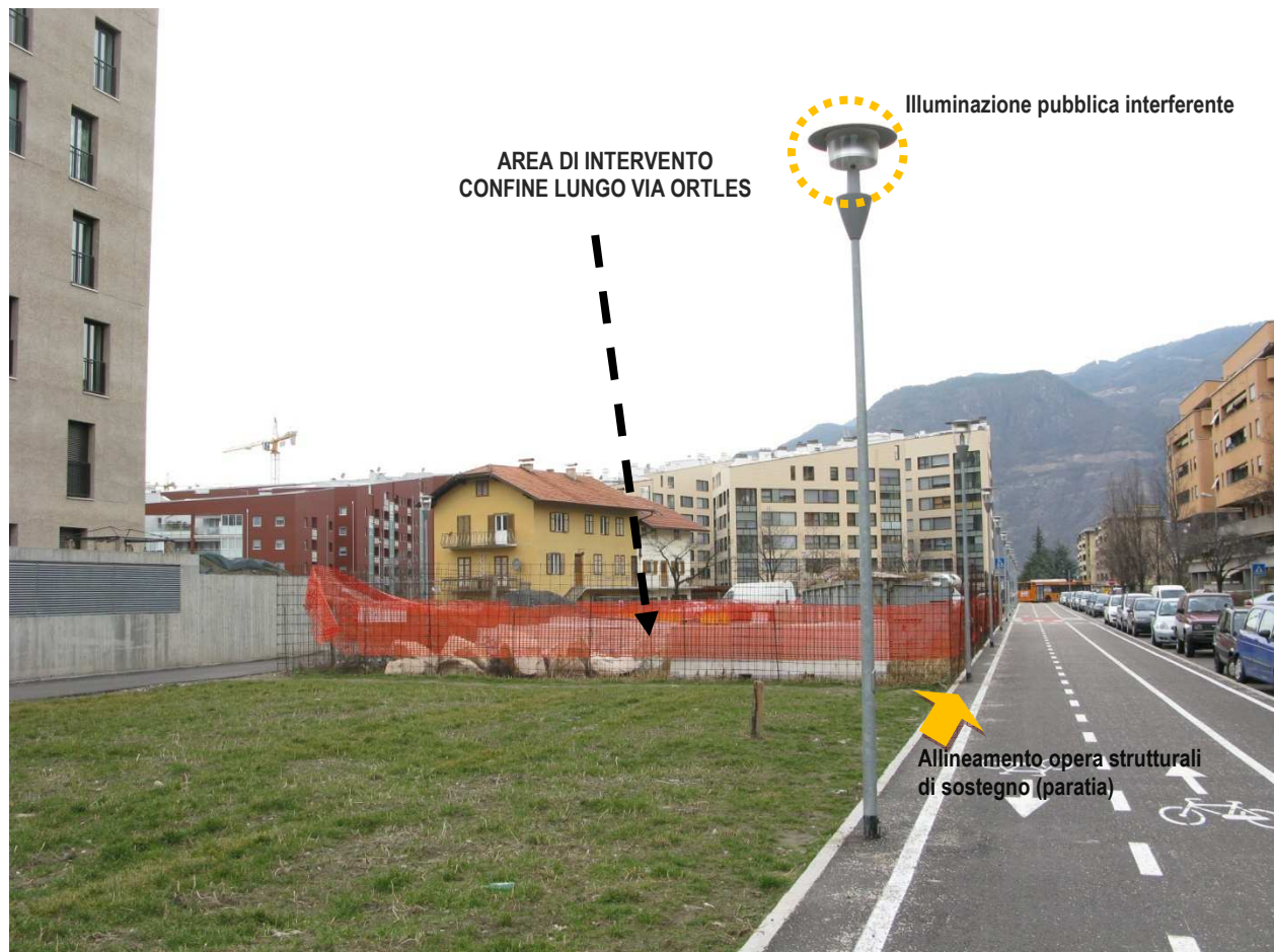
Foto 5 – Area di cantiere visto da via Ortles: percorso ciclopedonale e interferenze con le reti infrastrutturali
