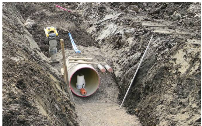
Kupplung zwischen zwei GFK-Rohren (links) sowie Eindrücke zu den Verlegearbeiten (rechts)
